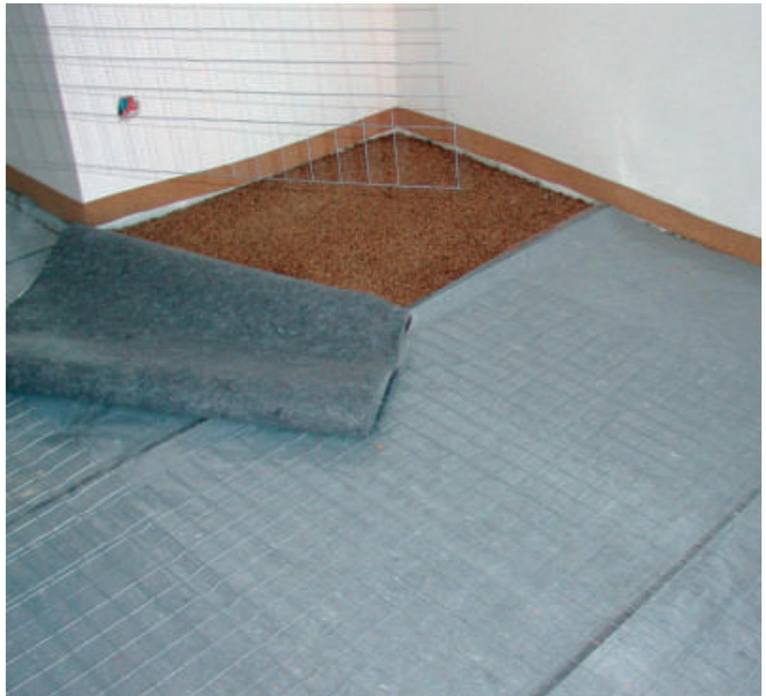
Particolare di sottofondo eseguito con pannelli di sughero biondo naturale compresso SoKoVerd.AF, strato separatore anticalpestio KoSep.F, rete elettrosaldata completo di strisce in sughero supercompresso KoFlex lungo il perimetro del locale
