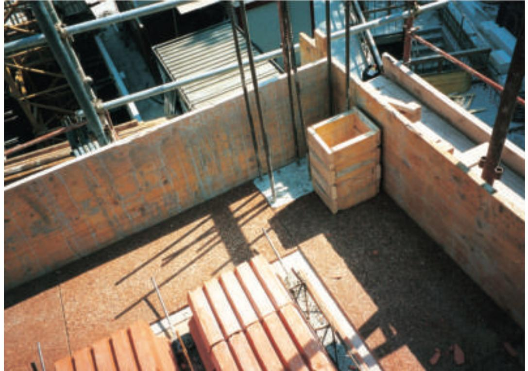
Protezione termoigrometrica delle corree e delle travi orizzontali con pannelli in sughero biondo naturale compresso SoKoVerd.AF
