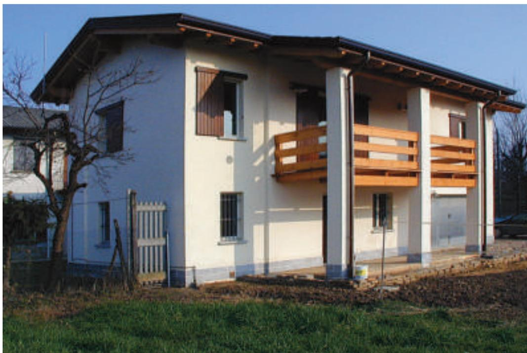
Esecuzione di intonaco di finitura colorata ai silicati di potassio
