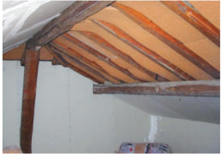
Recupero sottotetto con struttura in legno, isolamento con pannelli in sughero biondo naturale superkompatto e finitura in cartongesso
