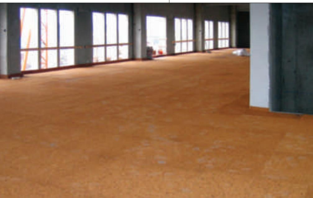
Sottofondo costituito da pannelli in sughero biondo naturale superkompacto SoKoVerd.LV con strisce lungo il perimetro, atto a ricevere lo strato separatore anticalpestio KoSep.L, la caldana in sabbia e cemento, il pavimento galleggiante. Coram Cologne (BS)
