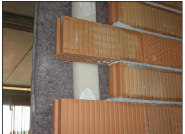
Parete divisoria costituita da blocchetti fonici in laterizio NKBL in inserito nell'intercapedine un sandwich formato da un doppio strato di ovatta con anima di laminato smorzante FoniVeg e un pannello in lana di pecora LanKot. Strisce in sughero biondo naturale supercompresso KoFlex sotto e sopra i tavolati.
