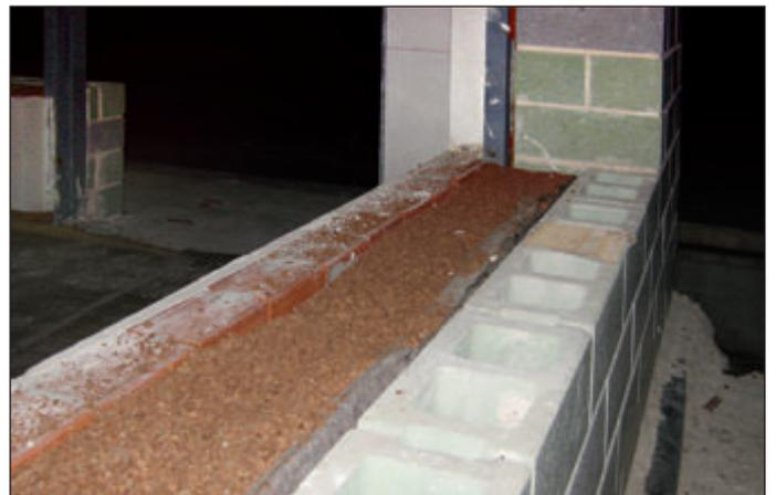
Pacchetto isolante costituito mediante un sandwich formato da un doppio strato di ovatta con anima di laminato smorzante FoniVeg, un pannello in lana di pecora LanKot e ulteriore riempimento della camera d'aria con granuli in sughero biondo naturale bollito e ventilato SugheroLite Costante 4mm
