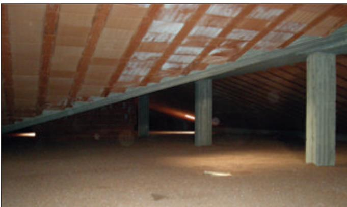
Isolamento del sottotetto con stesura granuli in sughero biondo naturale bollito e ventilato SugheroLite Costante 4mm.
