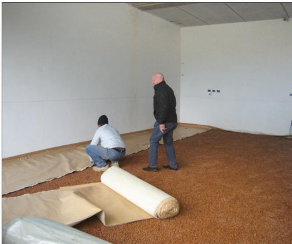
*Sopra il pacchetto isolante SugheroLite+KoGlass, posa dello strato separatore anticalpestio KoSep.L*
