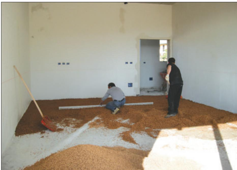
*Isolamento termico e acustico realizzato mediante l'impasto di sughero biondo naturale bollito e ventilato SugheroLite con legante vetrificante a presa aerea KoGlass di elevato spessore a copertura degli impianti.*
