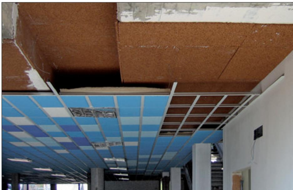
*Isolamento termico e acustico in una fase di cantiere. Pannelli di sughero biondo naturale SoKoVerd.LV ancorati sull'intradosso con la tecnica del cappotto e inserimento di pannelli in lana di pecora LanKot prima del telaio AlCover dove alloggianno pannelli Kontro per la correzione acustica.*
