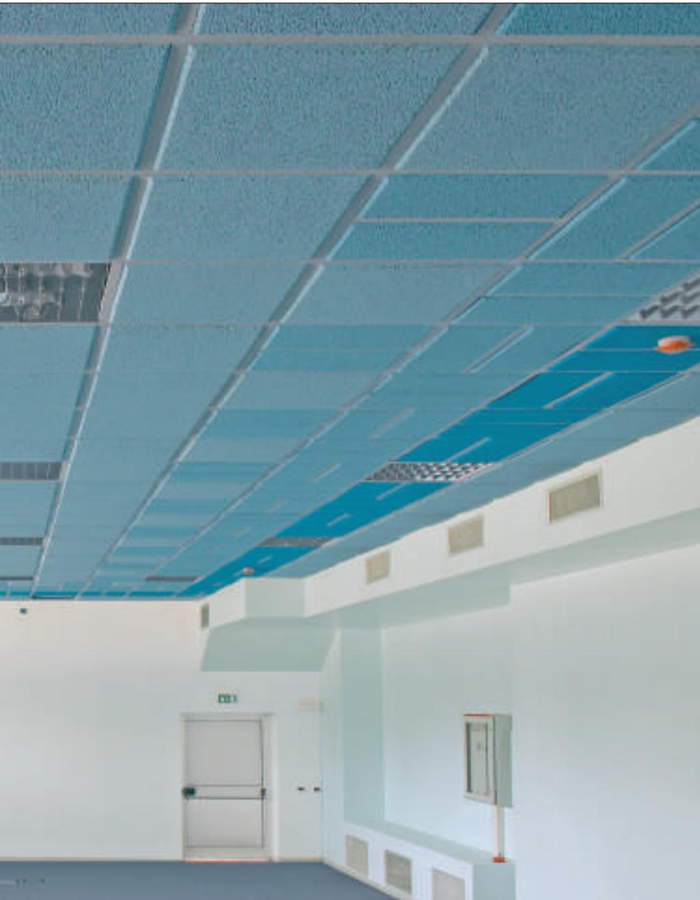
Nei corridoi, nell'atrio e nell'aula magna, la posa è stata fatta in abbassamento mediante una struttura metallica di supporto AlCover, mentre nelle aule, dove le norme impongono un'altezza interna di piano minima di 3 mt, i pannelli di sughero SoKoVerd.C1 sono stati incollati al soffitto.
