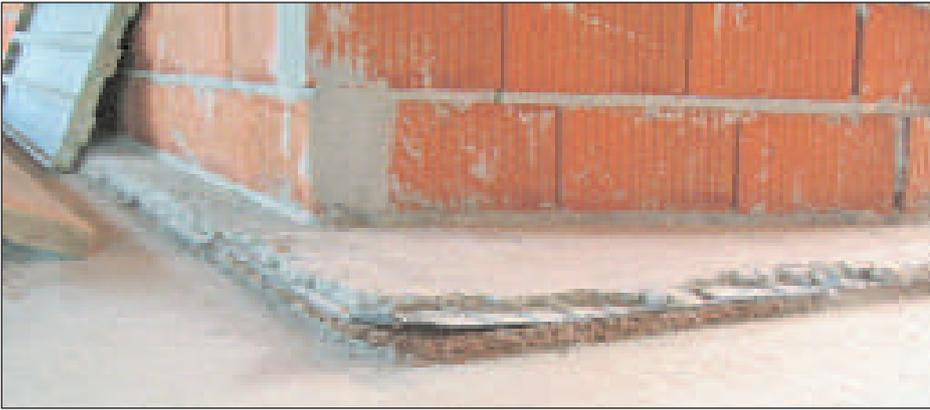
Particolare sottofondo con pannello di sughero biondo naturale superkompatto SoKoVerd.LV, strato separatore anticalpestio KoSep.F, rete elettrosaldata KoStell e caldana in sabbia e cemento
