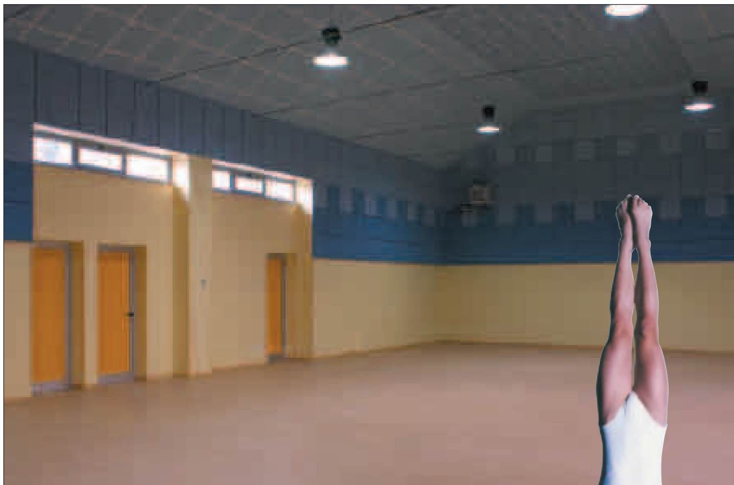
Palestra: il rivestimento del soffitto con pannelli Kontro ha conservato l'effetto a volta.
