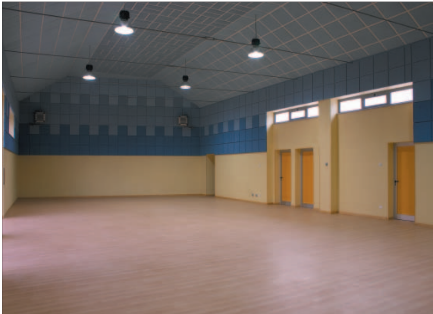
Sughero in pannelli Kontro sul soffitto e SoKoVerd C1 sulle pareti per una perfetta correzione acustica. Possibilità di scegliere colori e decorazioni, un aspetto importante degli ambienti aperti al pubblico
