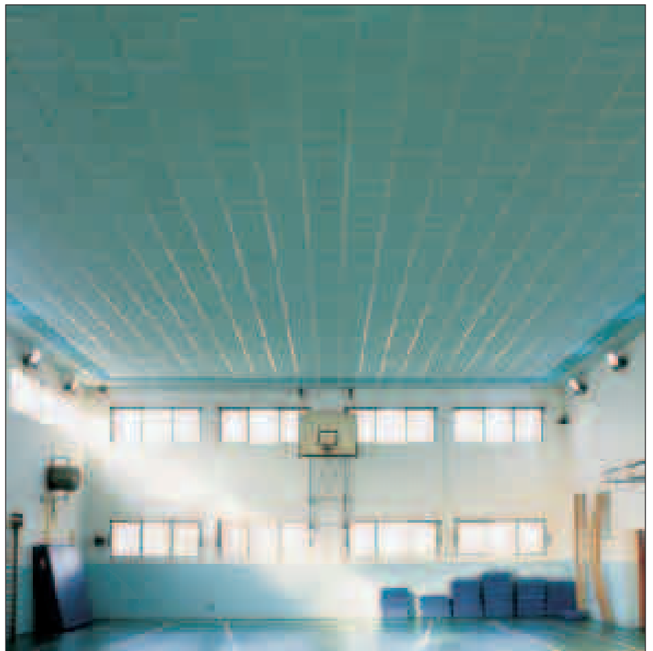
La palestra della scuola elementare Fortis, un esempio di correzione acustica con l'impiego di pannelli di sughero Kontro
