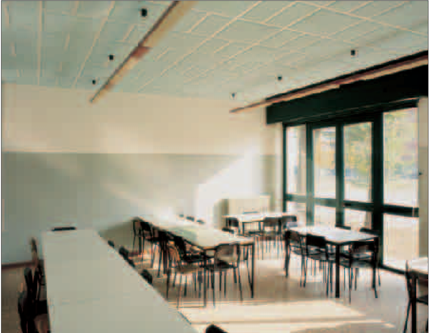
La mensa è un momento didattico ed educativo, il controsoffitto in sughero Kontro ha eliminato il "rimbombo" che causava stress ai bambini e al personale
