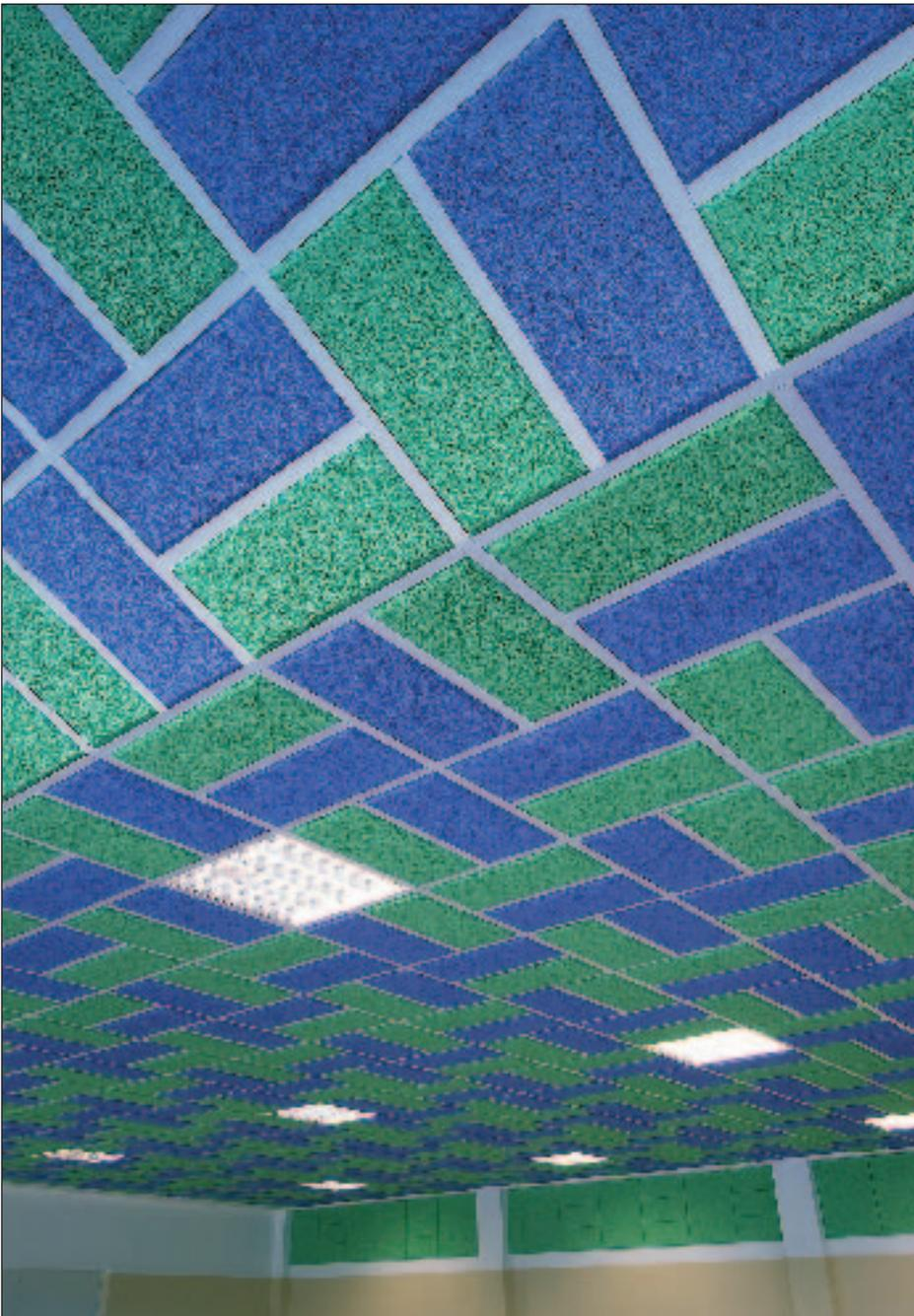
*I pannelli Kontro sono stati alloggiati negli appositi telai AlCover, progettati per garantire elasticità e durare nel tempo*
