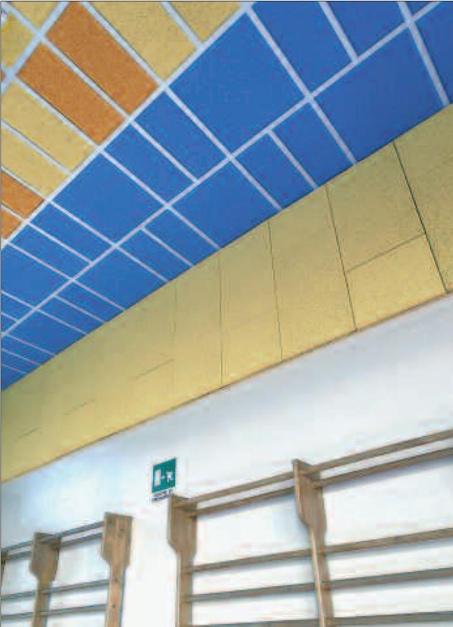
L'ottimo grado di fonoisolamento del sughero diminuisce le superfici che è necessario trattare
