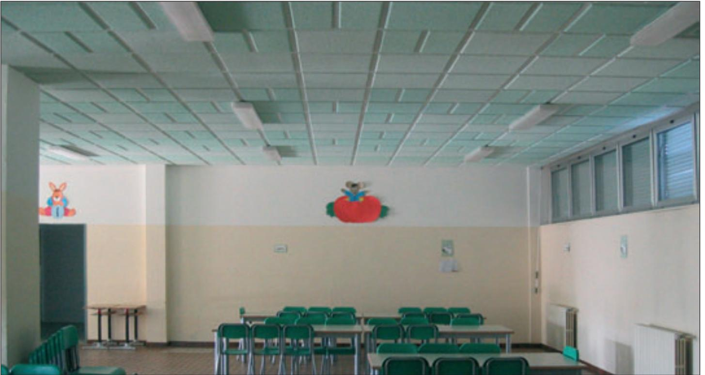
delle vie di fuga privilegiate dal rumore), che sono stati conservati ma "rinforzati" con l'aggiunta di un secondo telaio. Sul soffitto, infine, è stato eseguito un abbassamento fonoassorbente con pannelli di sughero Kontro alloggiati in telaio AICover. Il controsoffitto Kontro è stato esteso anche alla porzione ingresso.
