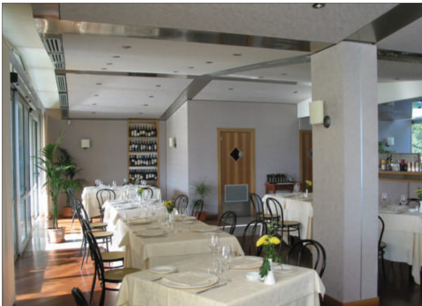
Soluzioni tecniche personalizzabili integrano la correzione acustica con gli elementi tecnologici per l'illuminazione e l'aerazione in questo moderno ristorante
