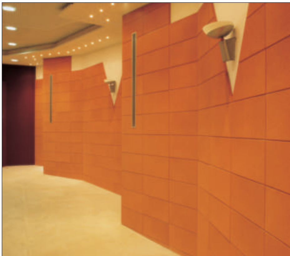
L'auditorium è stato insonorizzato con i pannelli in sughero SoKoVerd.C1 che hanno permesso di creare dei suggestivi coni luminosi sulle pareti. Brughiero – MI
