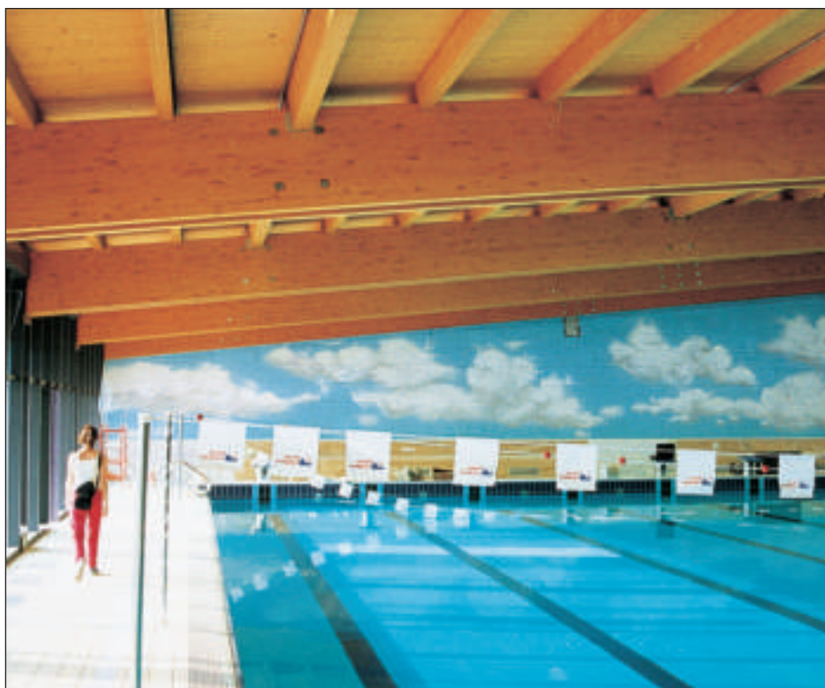
Piscina senza pareti? No... il piacevole effetto cielo è dato dall'affresco realizzato con vernici ad acqua su pannelli di sughero SoKoVerd.C1. Oggiono - LC
