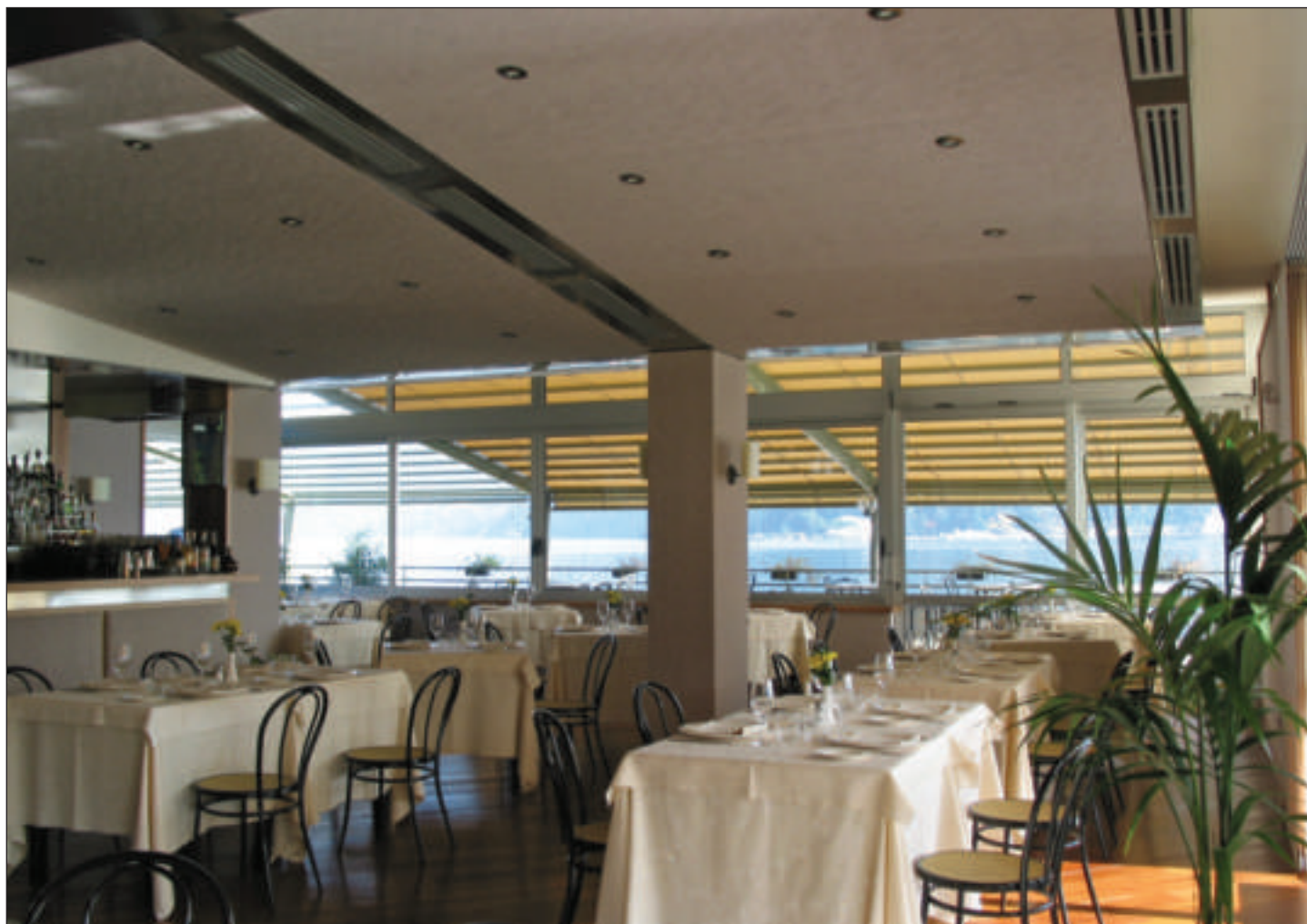
Un ristorante, ma anche una qualsiasi mensa, è un ambiente dove cerchiamo una pausa di relax. I rumori non devono infastidirci e nemmeno impedirci di chiacchierare con i commensali. La correzione acustica è stata realizzata a soffitto ed alle pareti con la tecnica del TeloTeso, una finitura molto elegante che permette di mascherare i pannelli di sughero biondo applicati alla sottostante struttura. Villa Olmo Lago Via per Cernobbio Como
