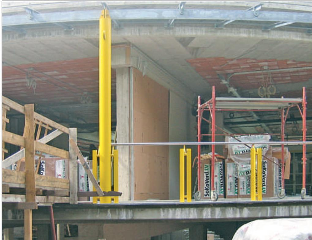
*Le partizioni verticali sono state isolate con pannelli di sughero SoKoVerd.LV per garantire il giusto comfort acustico e termico. Un progetto accurato, l'attenzione in cantiere e i prodotti CoVerd hanno permesso di risolvere anche il problema dei ponti termici e acustici.*
