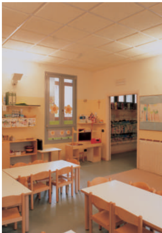
Aula Asilo - Controsoffitto in sughero Kontro
