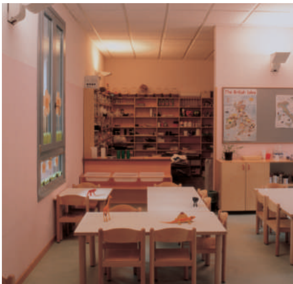
Aula Asilo - Controsoffitto in sughero Kontro
